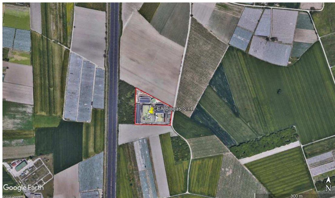
Figura 1: Ortofoto di inquadramento del complesso
